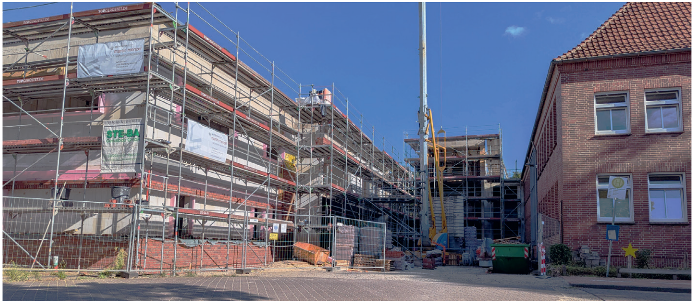
Der Anbau an die Tarmstedter Grundschule nimmt immer weiter Gestalt an. Pünktlich zum Beginn des Schuljahres 2026/27 soll er fertig sein.
