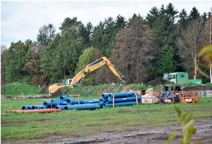
Derzeit werden die notwendigen Versorgungsleitungen verlegt.
