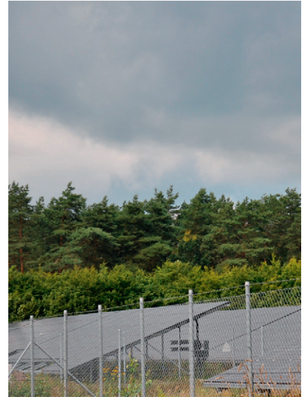
Freiflächen für Photovoltaik.
