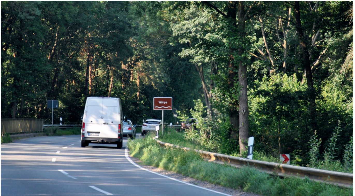
Die Wörpebrücke zwischen Tarmstedt und Wilstedt.
