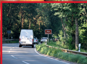
Bald ist es soweit: Die Wörpebrücke wird erneuert
